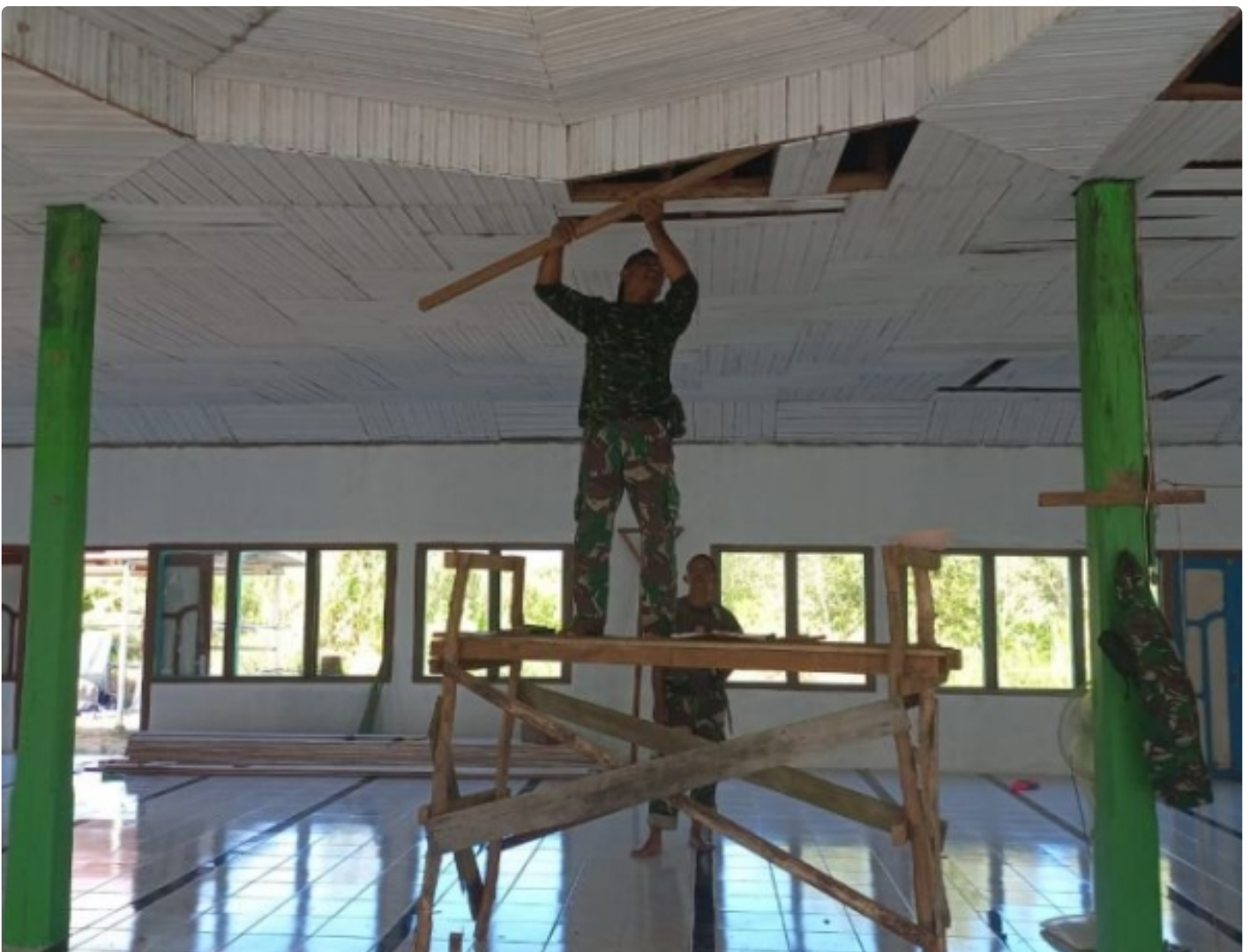
Satgas TMMD ke-113 Kodim 1005/Barito Kuala Pasang Plafon Masjid
