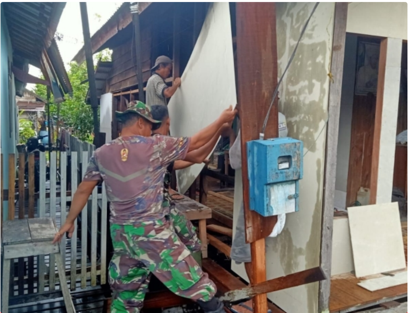
Rehab Rumah Tidak Layak Huni dalam rangka HUT Korem 101/Antasari sasaran ke-2 Rumah Ibu Sumiati Kodim 1005 Batola
