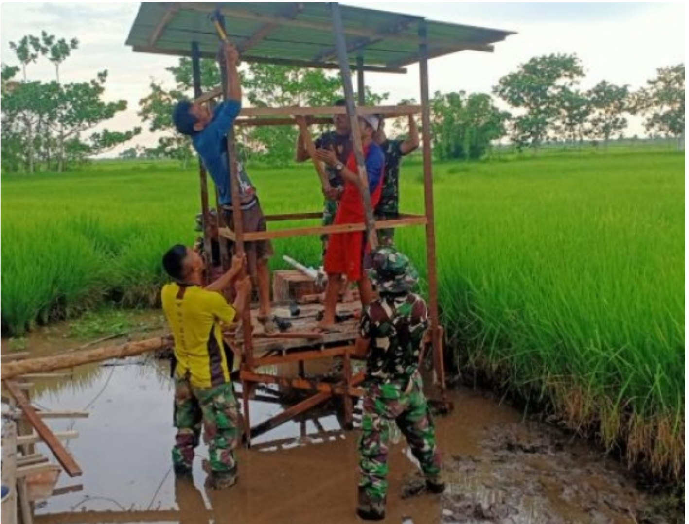
Pemasangan Atap WC
